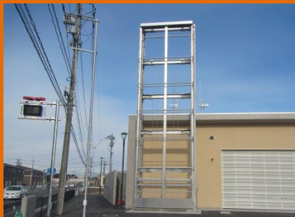
ホース乾燥塔
